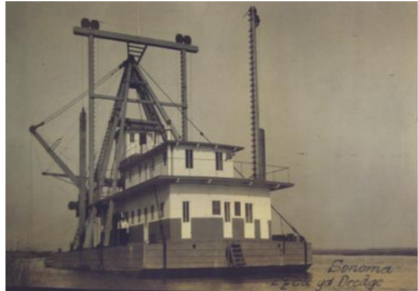
The dredge Sonoma , c. 1900.
